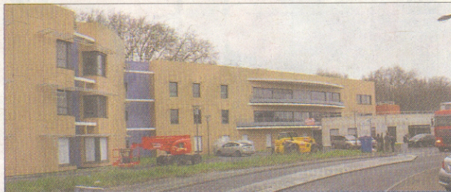
Le montant des travaux pour ce nouveau bâtiment de l'hôpital s'élève à près de 12 millions d'euros, hors frais de mobiliers
