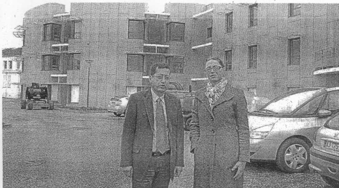
Les travaux du nouveau bâtiment de Machecoul ont commencé en septembre 2009. Derrière Pierre Vollot, le directeur, et Pascale Thezais, directrice-adjointe, la partie en cercle du bâtiment sera dédiée aux personnes désorientées.
